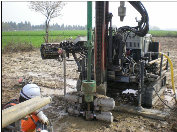
**FOTO 5** – ESEMPIO DI ESECUZIONE SPT NEL SONDAGGIO S1 (SPT1: 4.50-4.95M DA P.C.).
