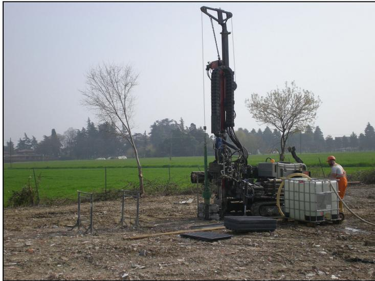
**FOTO 4** – ESECUZIONE SONDAGGIO A CAROTTAGGIO CONTINUO S1.
